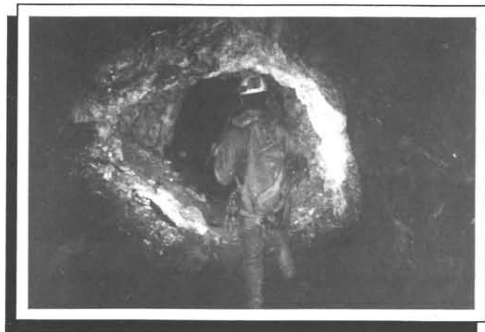
Túnel de la Verna
